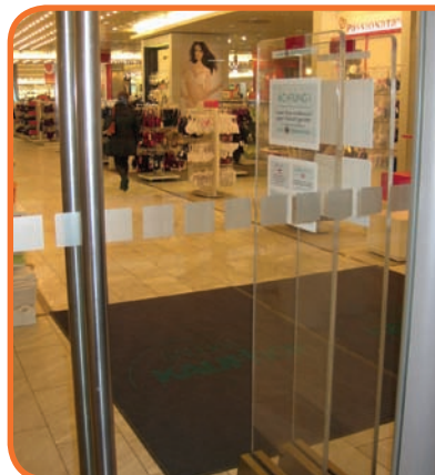
Beispiel für eine Eingangstür mit Markierung (Quelle: Galeria Kaufhof)
